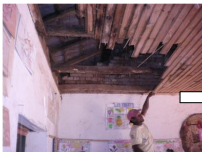
工事前の教室
