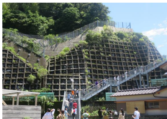
⑥徳島県美波町由岐地区にて。地区内の所々に設置されている避難階段を実際に上りました
